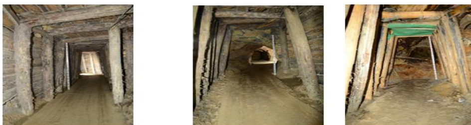
Fig. 2. Lucrări de armare pe Laterala 325 DR (GM10) – m 25, m 43 și m 68
