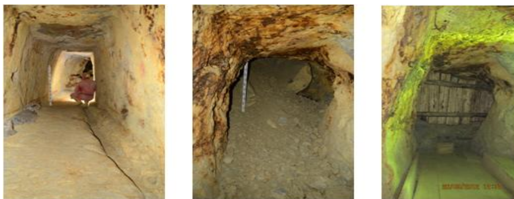
Fig. 3. Laterala 339 DR – galeria romană cu canal (G64 și G65), hornul cu material curs și gardonul din dreapta
