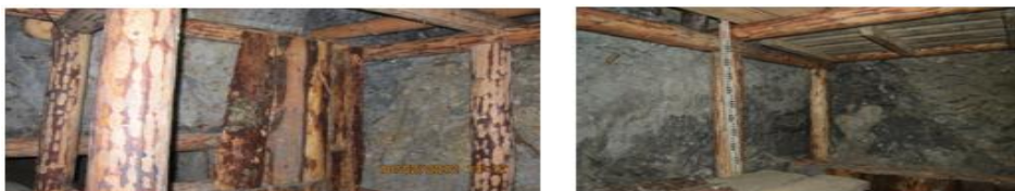
Fig. 1. Lucrări de armare în suitorul S 1 - în zona de interceptare a galeriilor antice
